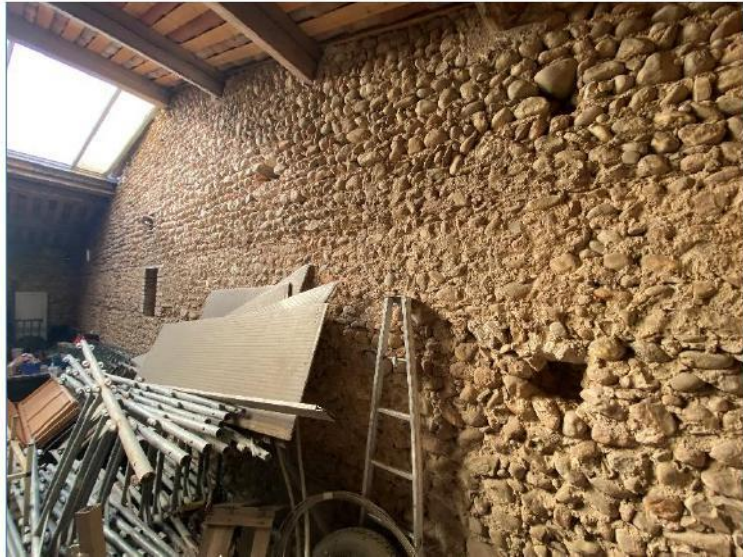
Le mur Sud-est est fissuré sur toute sa hauteur.
