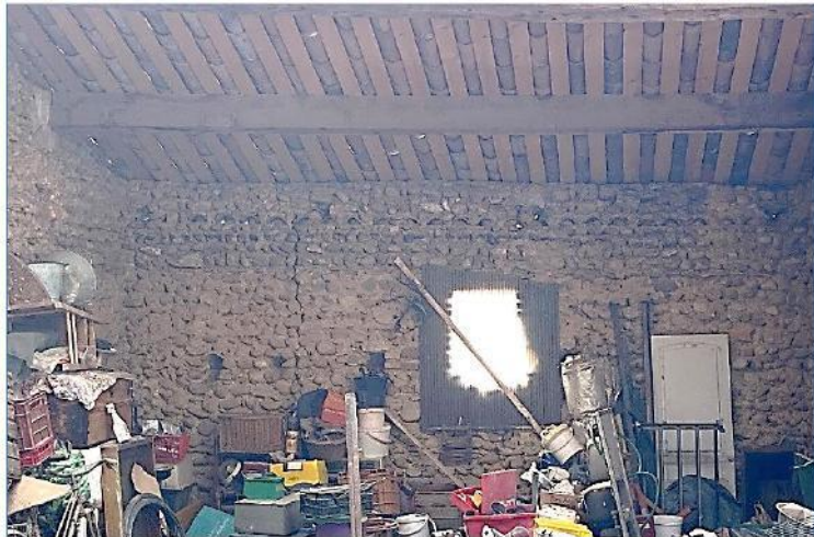
Le mur Sud-est est fissuré sur toute sa hauteur.
