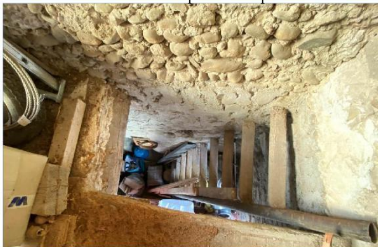
Echelle d'accès au plancher supérieure
