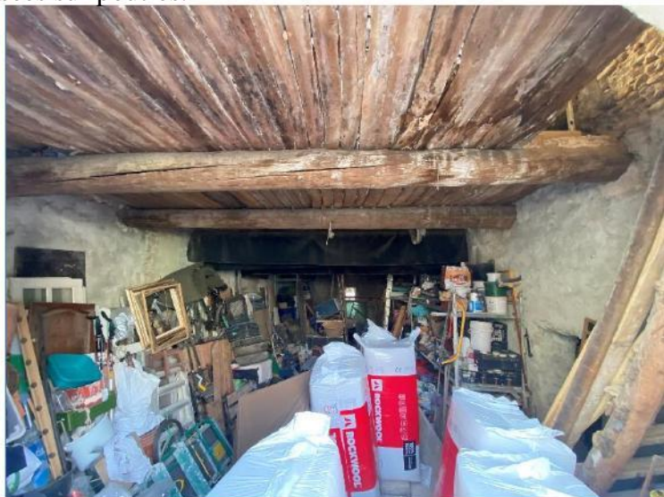
Le plancher supérieur, accessible par une échelle, est partiellement constitué de planches posées sur poutres.
